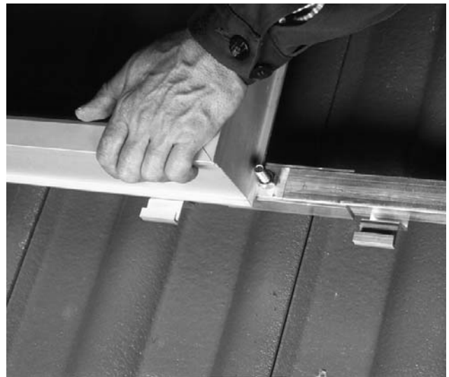
Bild 26 Nur bei senkrechter Anordnung zunächst Kollektoren in Aufdach-Kollektorhalter einsetzen.
