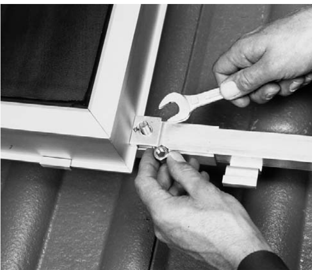
Bild 27 Nur bei senkrechter Anordnung anschließend Kollektoren seitlich mit Befestigungsklemmen so fixieren, dass eingepprägter Pfeil zum Kollektor zeigt. Dann nächsten Kollektor einsetzen.
