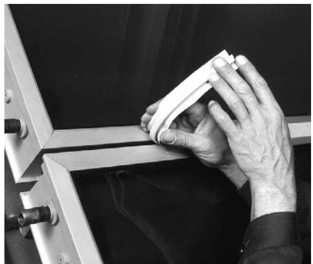
Bild 28 In die Spalte zwischen zwei Kollektoren Silikon-T-Profil einschieben oder drücken.
