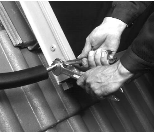
Bild 31 Gegenhalten beim Festziehen schützt Kollektoranschluss vor Schäden.
