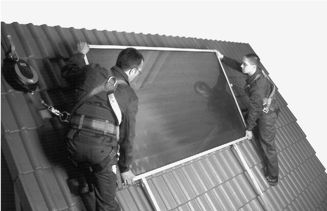
Bild 1 Die EURO-Kollektoren können Sie mit dem Aufdachsystem gut zu zweit montieren ohne zu löten und ohne das Dach zu öffnen.
