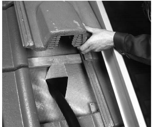
Bild 32 Unterspännbahn einschneiden, hochklappen, fixieren und Lüfterziegel einsetzen. Wellschläuche an Solarkreis anschließen und nach Abdrücken Rohrisolierungen bis an Kollektor ziehen.
