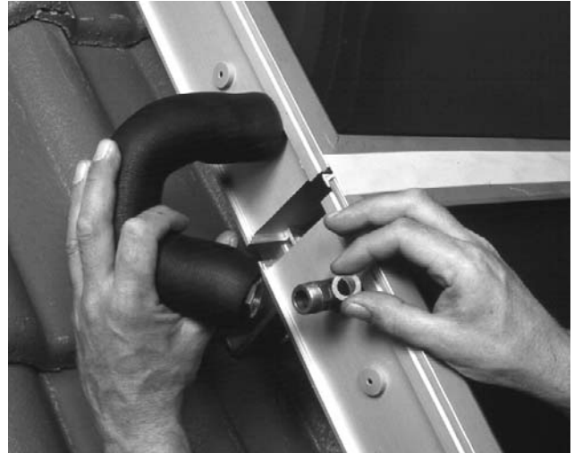
Bild 30 Kollektoren mit Edelstahlwellschläuchen verbinden. Auf Dichtungsringe achten
