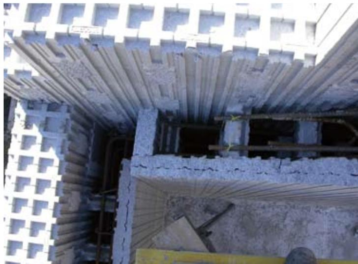
Dettaglio muratura perimetrale prima del getto in cemento - 23 centimetri di isolamento termico.
