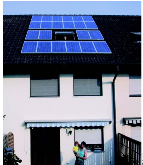
Zukunftsinvestition made by W-Quadrat: Bei Familie Hermann im badischen Gernsbach beschert eine 2,64-Kilowatt-Solaranlage mit 22 Modulen vom Typ IBC-120 S Megaline der nachwachsenden Generation eine umweltfreundliche Stromquelle.
