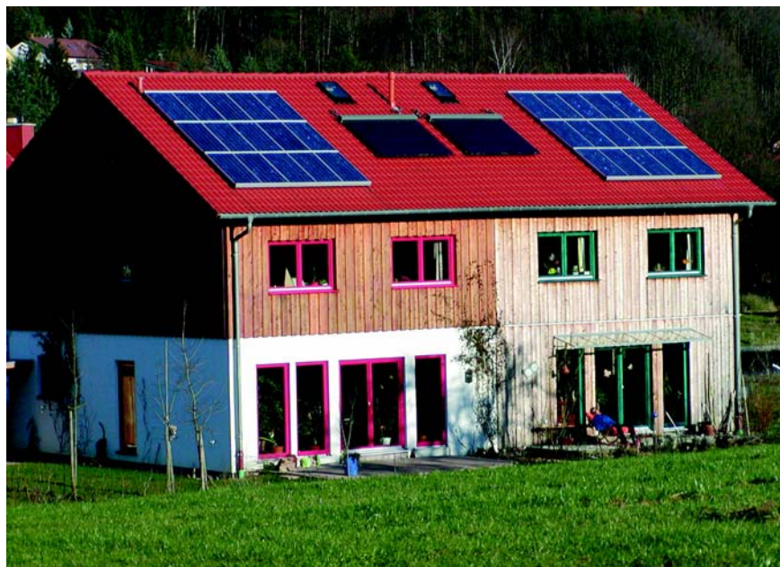
Sonnenfänger installiert von Ralos: Auf dem ideal nach Süden ausgerichteten Dach dieses Zweifamilienhauses in Erbach im Odenwald ist Platz für eine 3,6-Kilowatt-Solarstromanlage mit 30 Ralos-Modulen vom Typ Ra 120 P sowie zwei Sonnenkollektoren.
