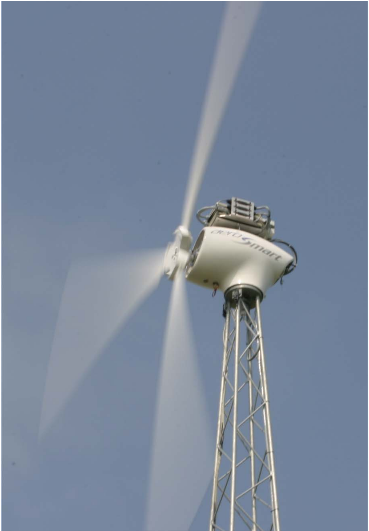
Anlage mit umfangreichen Messeinrichtungen in der Erprobungsphase
