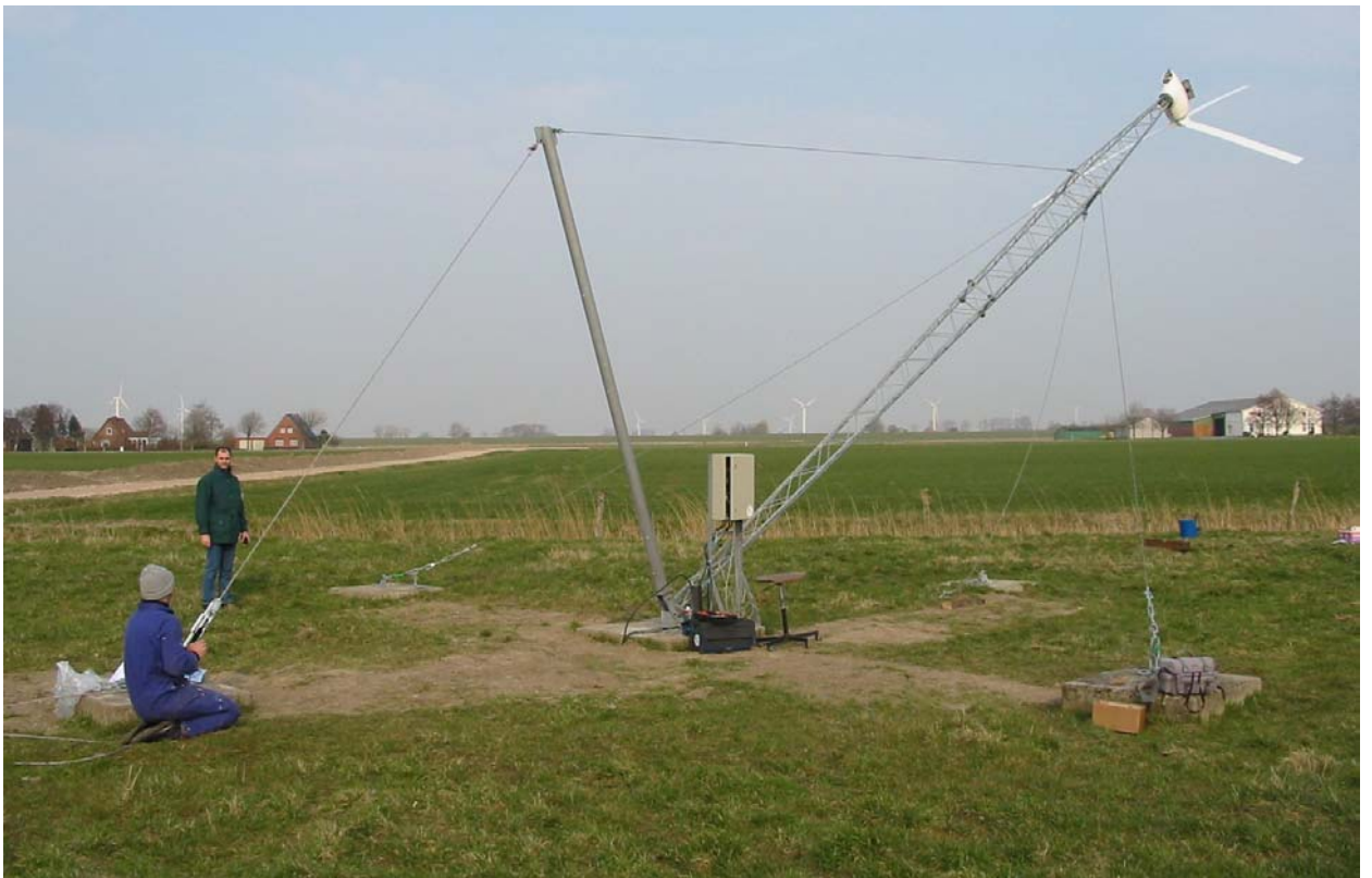
Anlage bei Montage und Errichtung auf Testgelände
