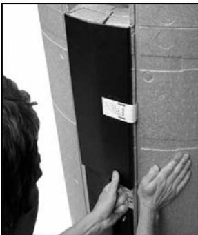
Auf der rechten Seite die Profile aus der Dämmung ziehen, links eingesteckt lassen
