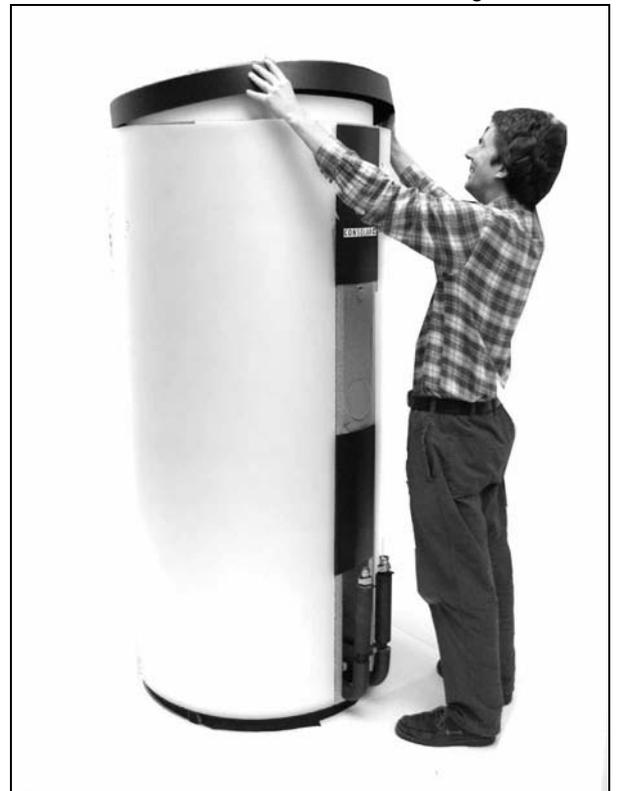
Wenn der Speicher fertig gedämmt ist, können die angeschlossenen Rohre gedämmt werden. Dabei sind die Rohrdämmungen dicht an den Speicher zu führen.
