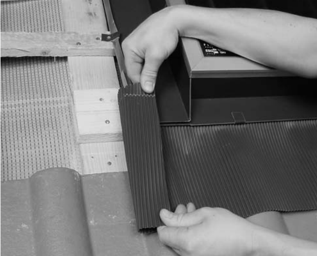
Bild 29 Bleischürze über Seitenbleche umschlagen.
