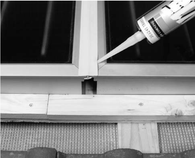
Bild 17 Zwischen Profillflügel des T-Profils und Kollektorrahmen zum Abdichten dünn Silikon auftragen.
