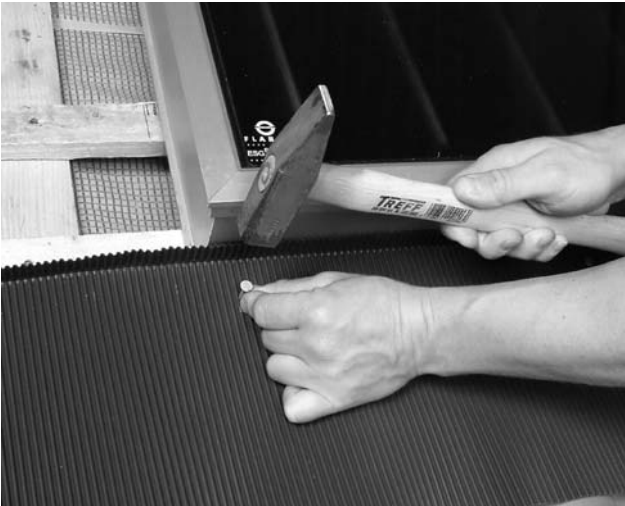
Bild 23 Bleischürze mit Kante an Unterseite des Kollektors schieben und mit Dachpappnägeln (5 Stück pro Kollektor) dicht an der Prägung festnageln. Bleistreifen seitlich etwa 15 cm überstehen lassen.
