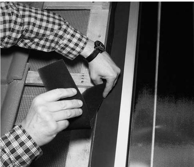
Bild 37 Auch an den Seitenblechen entlang des Falzes die Schaumstoffstreifen aufkleben.
