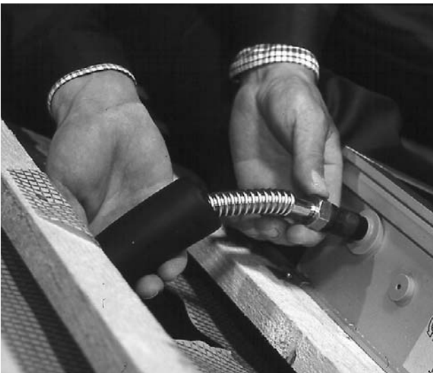
Bild 19 Wellschläuche an freie Kollektoranschlüsse und unterm Dach an Cu-Rohr des Solarkreises (mit 1/2"-18 mm Nippel) anschließen. Verbindungen abdrücken, falls später Dachunterseite geschlossen ist.
