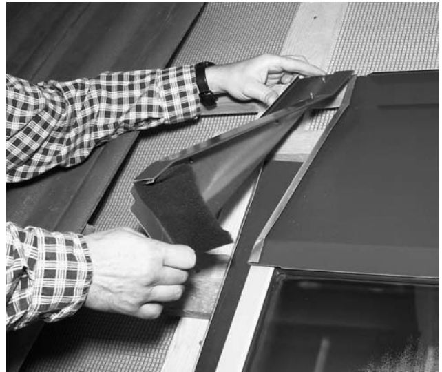
Bild 32 Eckstück zur seitlichen Abdichtung mit einem, auf 11 cm abgelängten, schwarzen Schaumstoffstreifen bekleben und in oberes Abdeckblech einhaken und nach außen ziehen.
