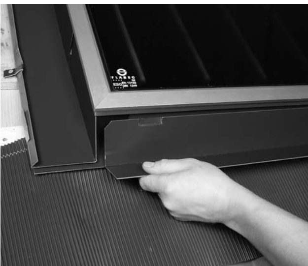
Bild 27 Abschlussbleche unten - am linken Kollektorrand beginnend - in Kollektornut einstecken.
