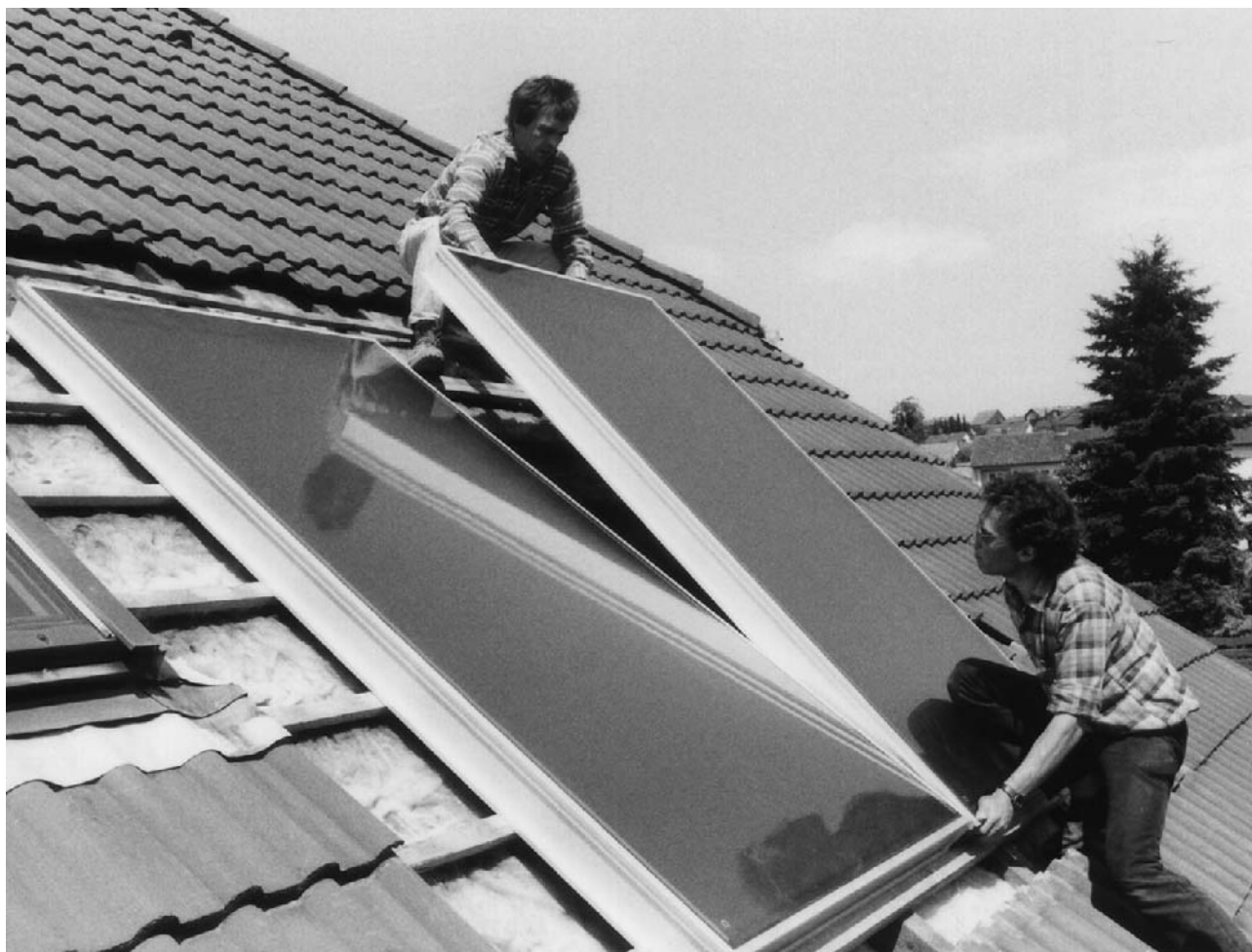
Bild 1 Das EURO-Kollektor Indachsystem lässt sich zu zweit bequem installieren und fügt sich ansprechend in die Dachhaut ein.
