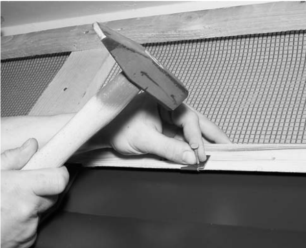
Bild 35 Obere Abschlussbleche mit 2 Blechhaften pro Blech auf der Dachlatte befestigen.
