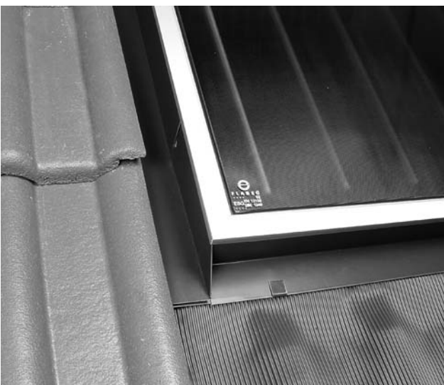
Bild 39 Zum Schluss Bleischürze an Ziegel anpassen. So sind die Kollektoren ansprechend ins Dach eingebunden.
