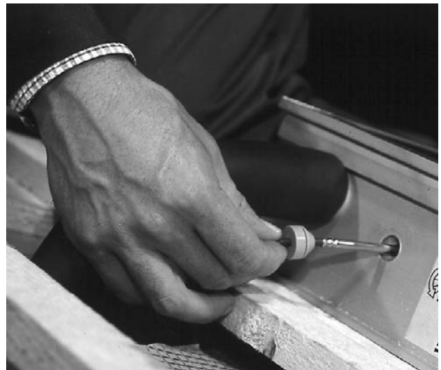
Bild 20 Solarfühler in Fühlerhülse am Kollektorausstritt stecken. Gummistopfen auf Kabel schieben und damit Öffnung verschließen. Kabel ins Dach führen.
