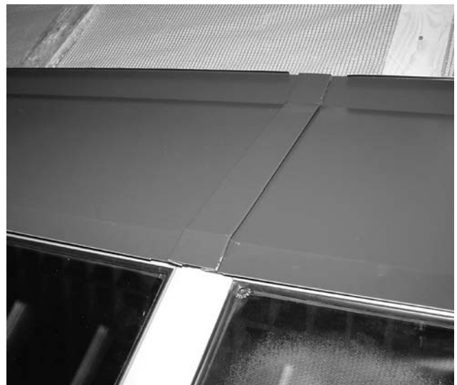
Bild 34 Sind alle oberen Blechteile zusammengefügt, die gesamten oberen Bleche nochmals auseinander ziehen, damit die Bleche mit wenig Spiel verbunden sind.
