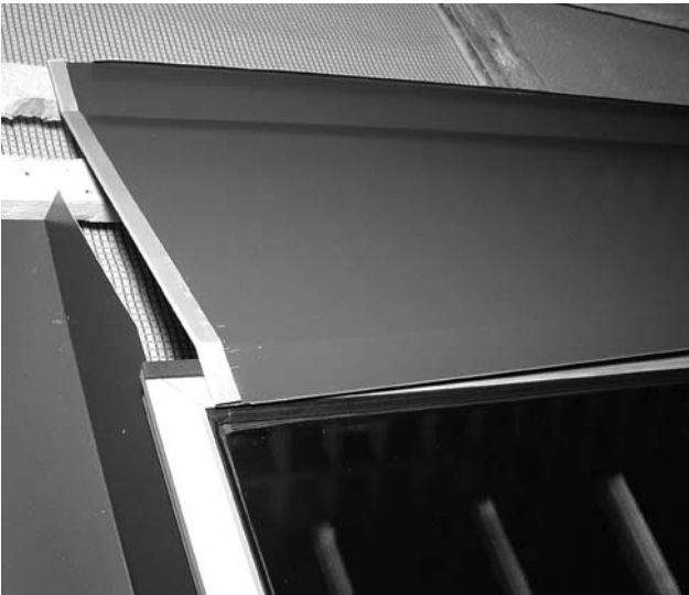
Bild 31 Oberes Abschlussblech auflegen und mit Blechnut in Kollektorfalz einschieben.
