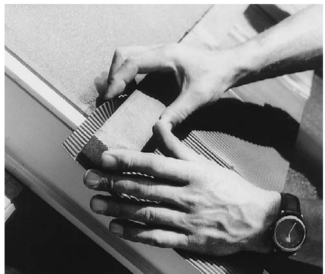
Bild 22 Bleischürze (unten) mit Hilfe einer Latte an der Prägung um 90° hochbiegen.
