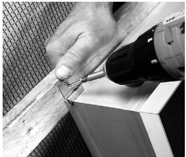
Bild 16 Sonnenkollektor oben jeweils links und rechts an der Kante mit Kollektor-Indachhaltern und vier Schrauben auf Latten festschrauben.
