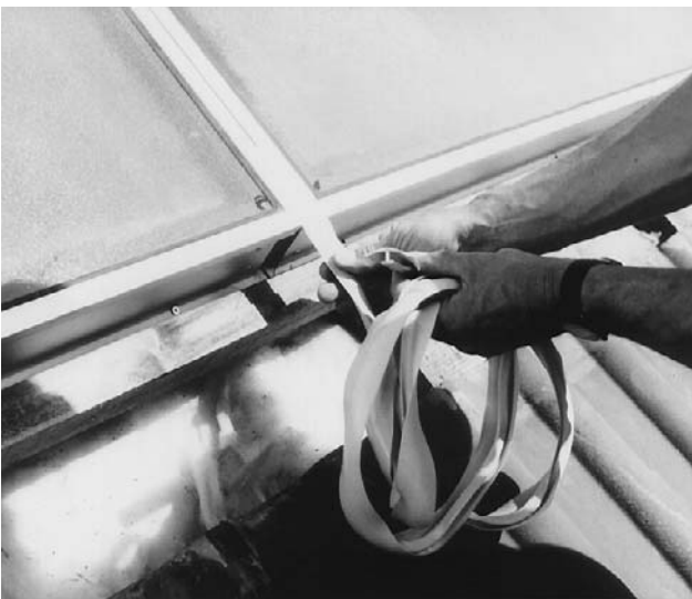
Bild 15 In die Spalte zwischen den Kollektoren Silikon-T-Profil einschleiben. Abwechselnd drücken und ziehen erleichtert die Arbeit. Anschließend die Kollektoren bündig zusammenschieben.
