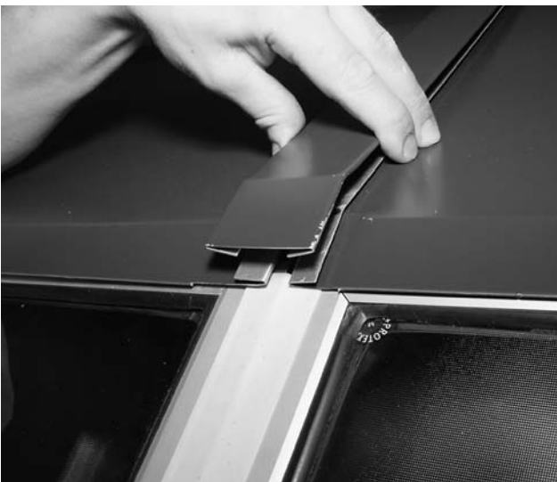
Bild 33 Weitere obere Abdeckbleche bündig anlagen, Verbindungsblech auflegen und Abschlussbleche auseinander ziehen.
