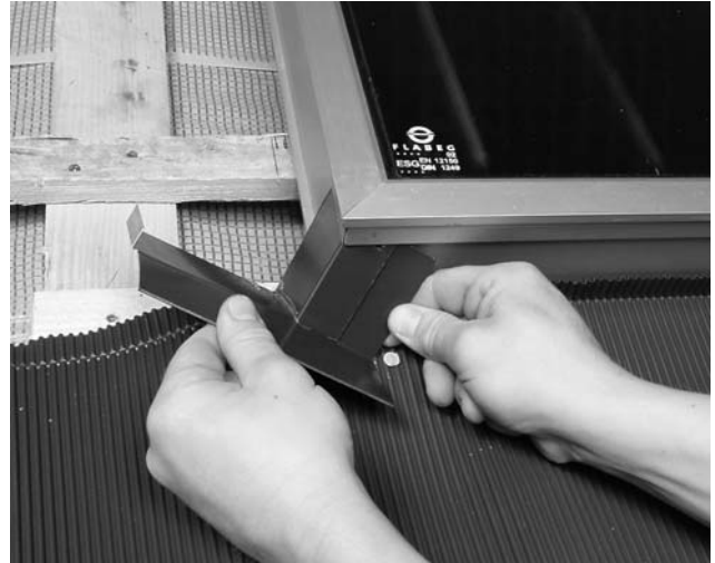
Bild 24 Eckstücke in die tiefere Nut am Kollektor einschieben und an Kollektorecke andrücken
