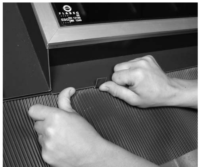
Bild 28 Blechlaschen umbiegen Abschlussbleche unten an Kollektor andrücken und durch Umbiegen der Blechlaschen fixieren.
