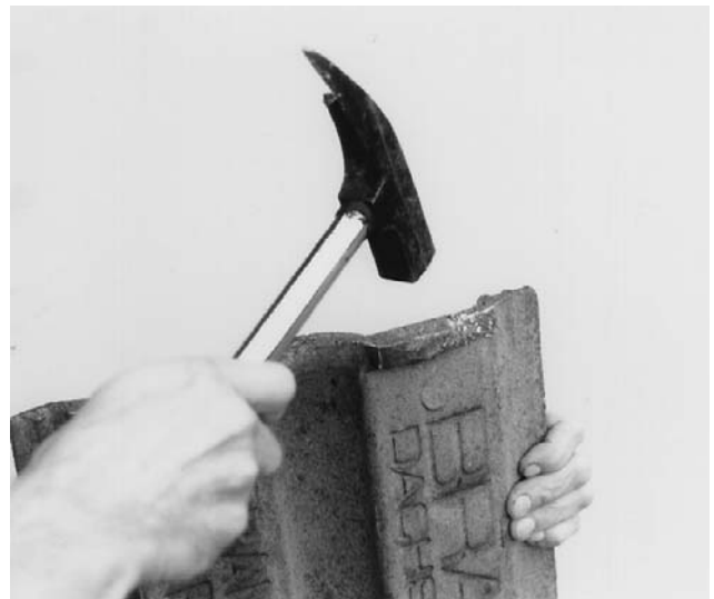
Bild 38 Wenn Sie die Ziegel auf Seitenbleche legen ggf. eine Einhängenocke abschlagen, Ziegel durchbohren und auf Latte (nicht auf dem Blech) festschrauben.
