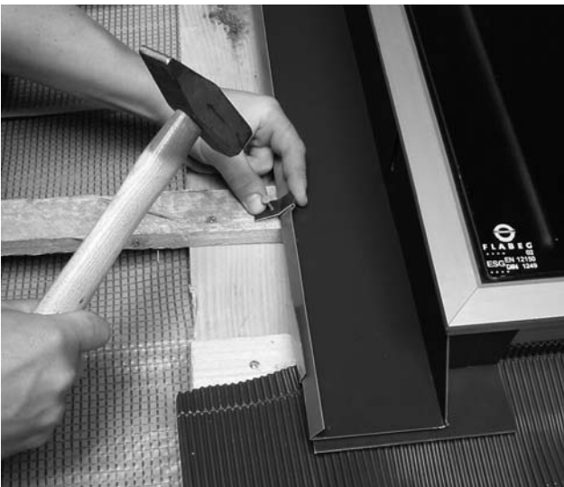
Bild 25 Seitenblech ebenfalls in die tiefere Nut am Kollektor einstecken und so weit wie möglich nach unten schieben und mit Befestigungshaft festnageln
