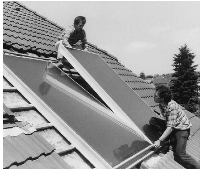
Bild 14 Kollektoren in schräge Latte B gleiten lassen. Zunächst zwischen Kollektoren - zum Einsetzen des Silikon-T-Profils - einen gleichmäßigen Spalt von ca. 8mm lassen, ggfs. Latte B nachjustieren.
