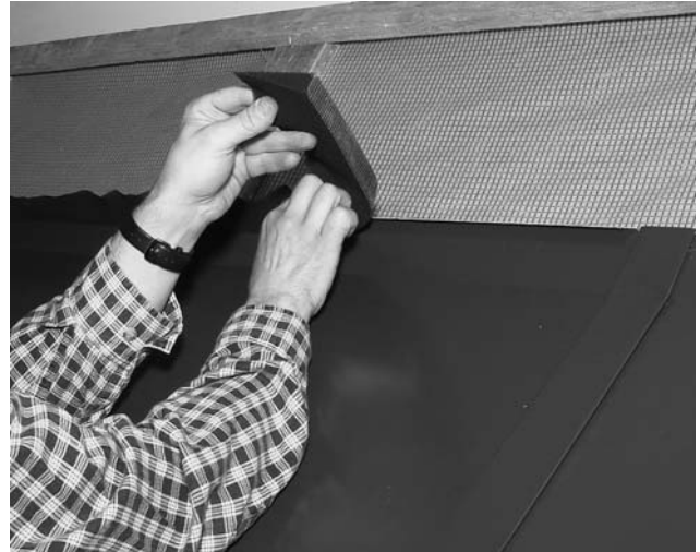
Bild 36 Auf oberes Abschlussblech entlang des Falzes schwarzes Schaumgummiband aufkleben.
