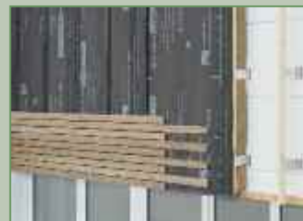
Anbringen der Holzschalung.
