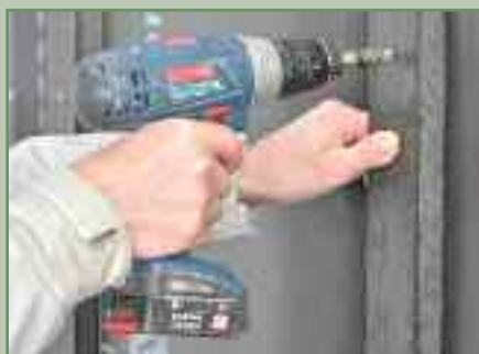
Montage der Hinterlüftungsebene (bei Holz-Schalung).
