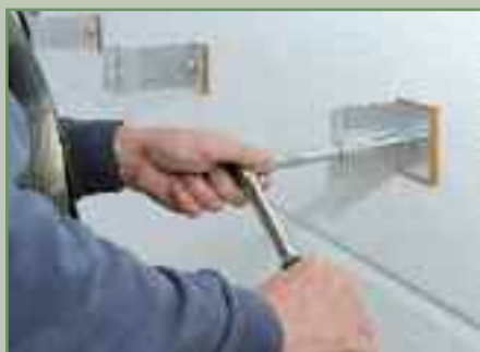
Einteilung der Abstände und anschrauben der Distanzhalter.
