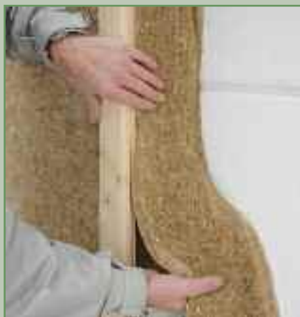
Einlegen der Thermo-Hanf® Dämmstreifen in die Stege.
