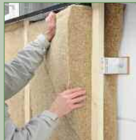
Einbau der Thermo-Hanf® Matten.
