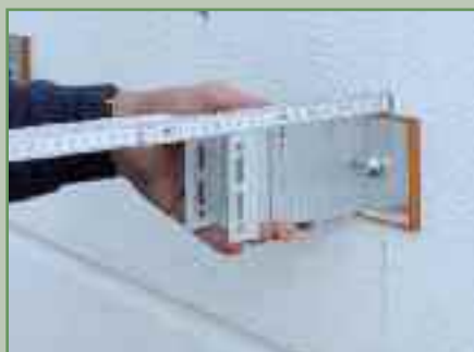
Festlegung der Dämmstärke.
