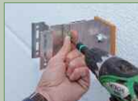
Ausrichten und Anschrauben der Profilhalter.
