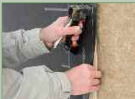
Anbringen der Winddichtungsbahnen.
