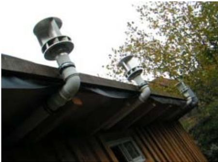
Savoniusrotor Windlüfter der TC-Anlage in Osnabrück
