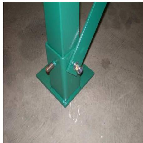
Als nächstes die Zugstreben auf die Stehbolzen der Kopf – und Fußstücke stecken und jeweils mit einer Mutter M12 sichern.
