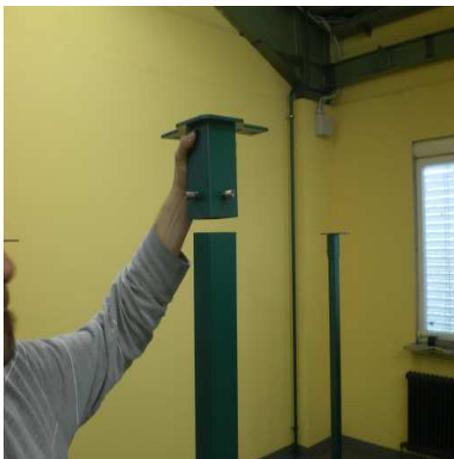
...und die Kopfstücke (jeweils 4 Bohrungen) so auf die Stützen stecken, dass die Bolzen für die Zugstreben nach außen zeigen.
