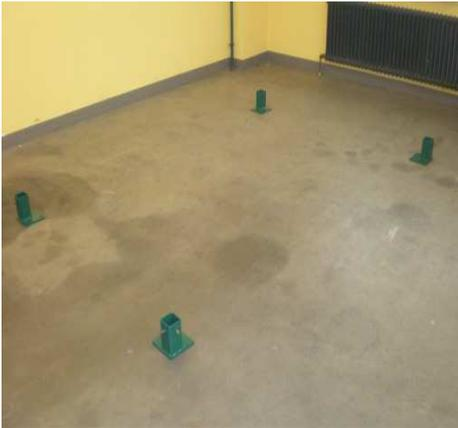
Die 4 Fußstücke (jeweils 1 Bohrung) so auf dem Boden positionieren, dass die Bolzen für die Zugstreben nach außen zeigen.
