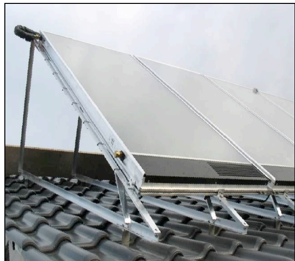
Beispiel: angehobene Schrägdachmontage
